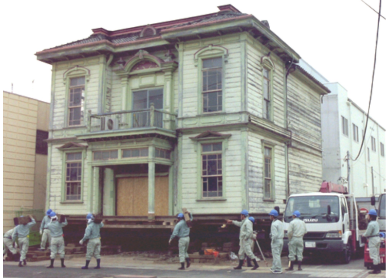
伊勢崎市指定重要文化財いせさき明治館(黒羽根内科医院旧館・旧今村医院) 移設工事
